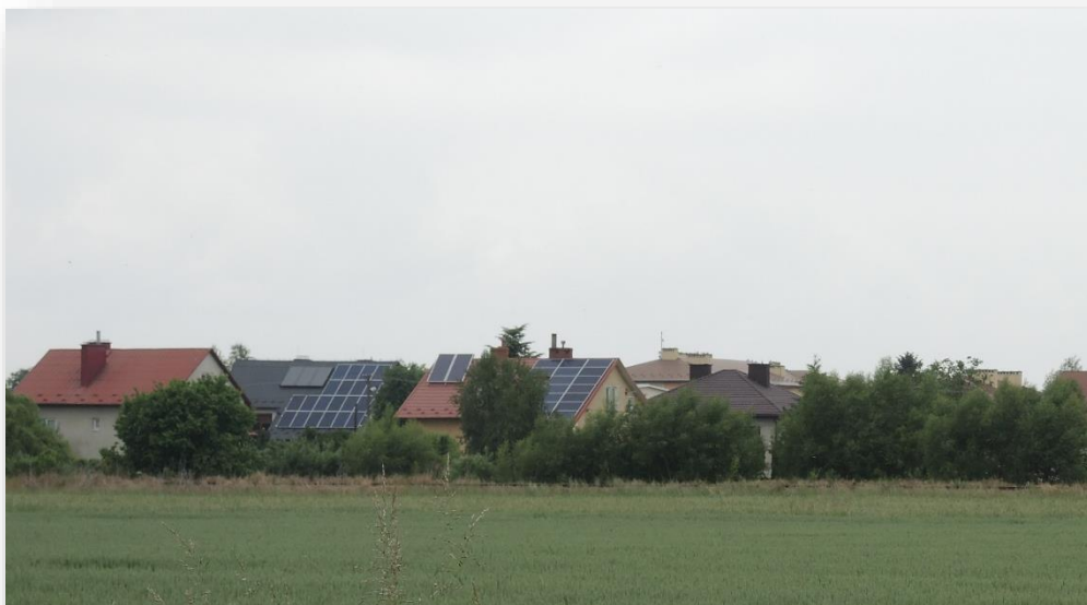
Realizacja projektu „Eco-energia w gminach Padew Narodowa, Borowa i Gawłuszowice” w ramach RPO WP Oś Priorytetowa III Czysta Energia
