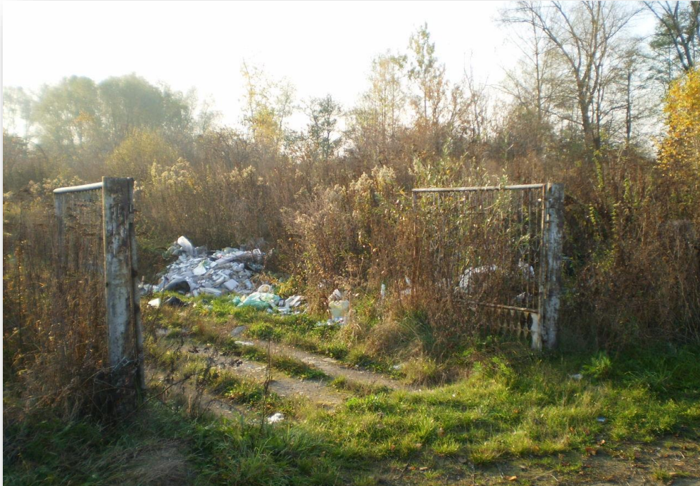
Teren składowiska odpadów przed rekultywacją – główna brama wjazdowa
