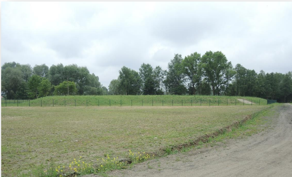
Rekultywacja składowiska odpadów innych niż niebezpieczne i obojętne w Padwi Narodowej
