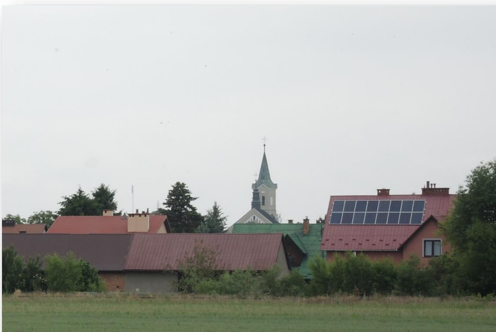
Realizacja projektu „Eco-energia w gminach Padew Narodowa, Borowa i Gawłuszowice” w ramach RPO WP Oś Priorytetowa III Czysta Energia
