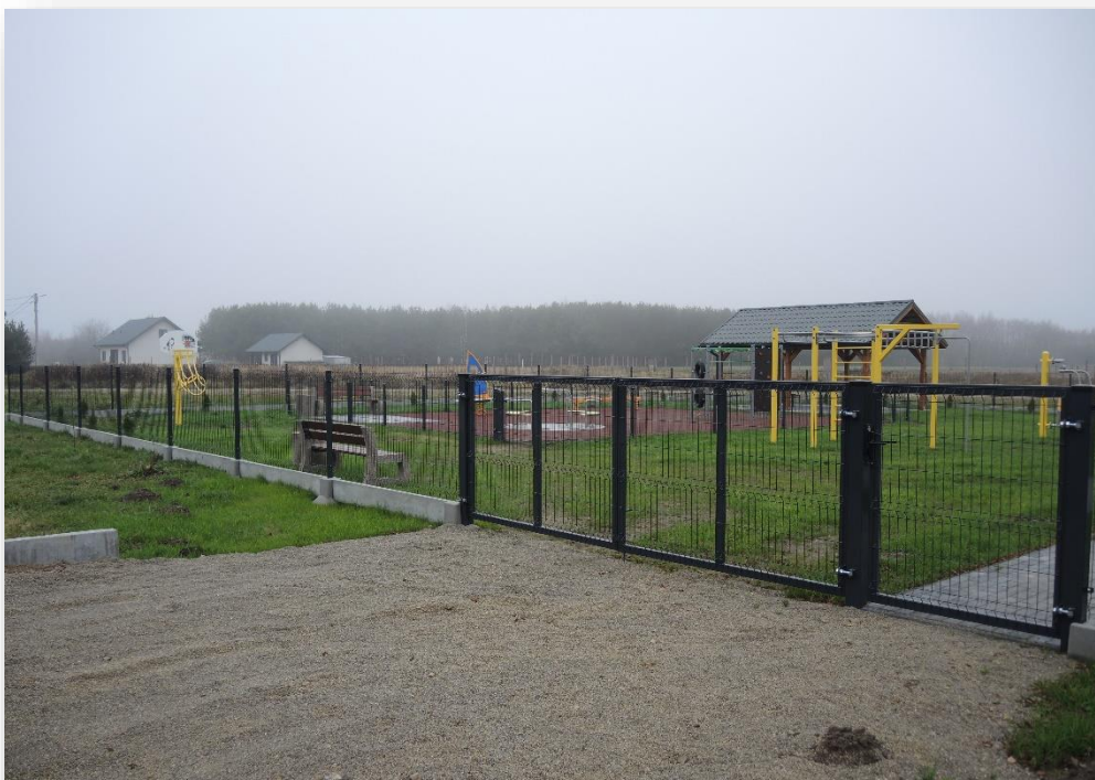
Budowa Otwartej Strefy Aktywności w miejscowości Padew Narodowa, Gmina Padew Narodowa
