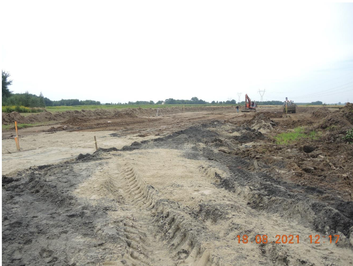
Budowa drogi kategorii D w terenach inwestycyjnych
