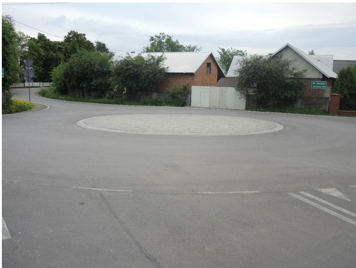
Rondo w ciągu drogi powiatowej w miejscowości Piechoty
