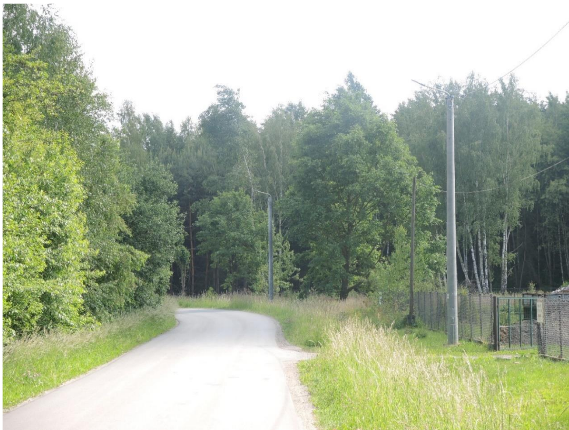
Budowa oświetlenia ulicznego w Kębtowie (Tarnówek)
