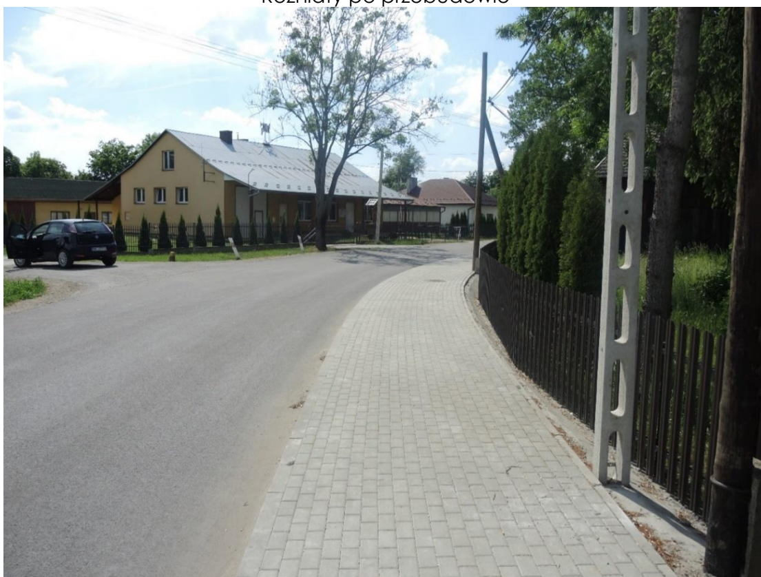
Droga powiatowa Padew Narodowa - Przybyły- Roźniaty w miejscowości Padew Narodowa po przebudowie
