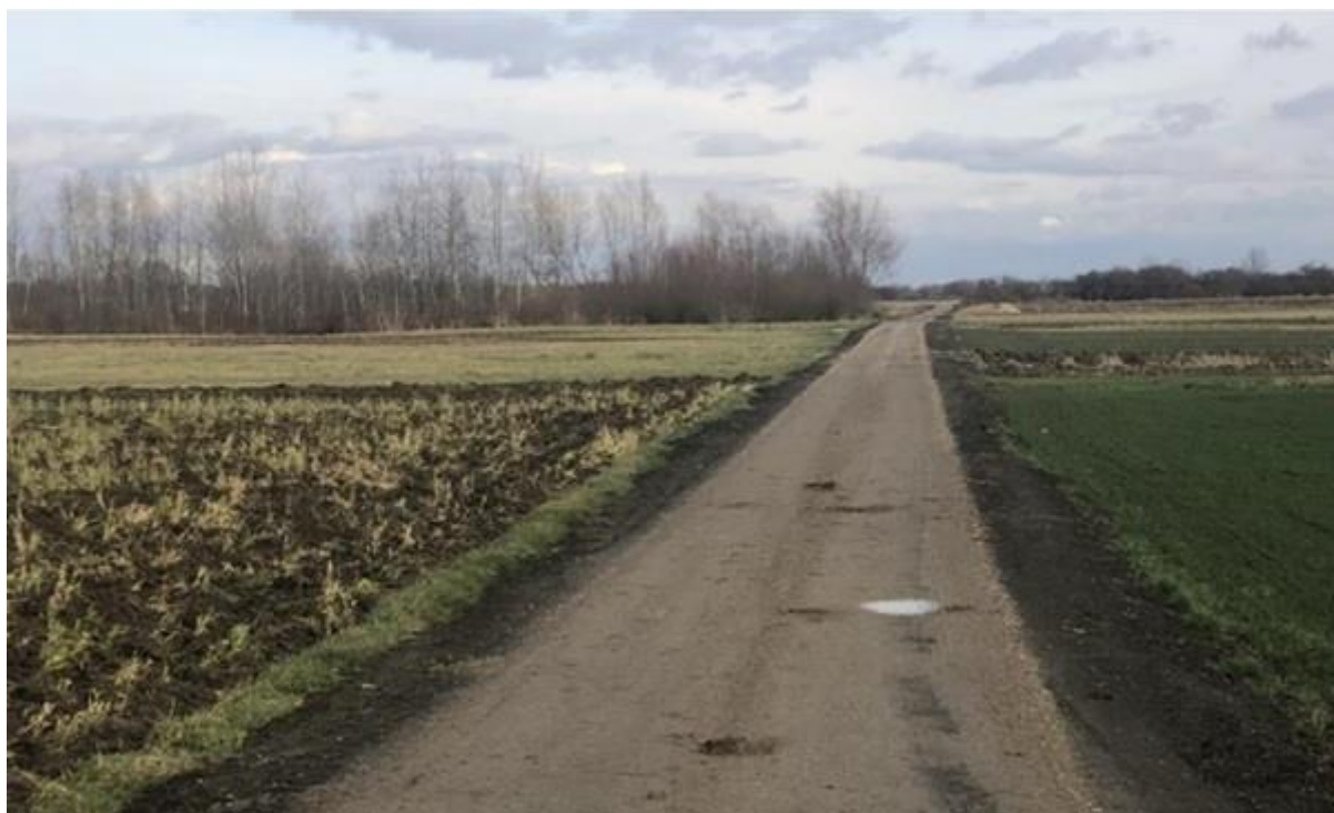
Droga „Niciecka” w Przykopie po modernizacji
