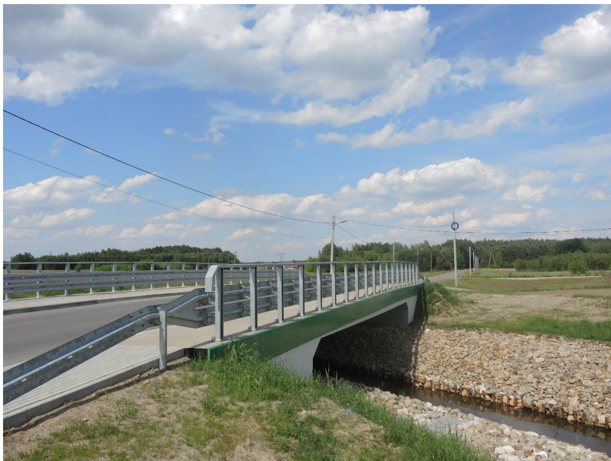
Most w Zachwiejowie na rzece Babulówka w ciągu drogi powiatowej- po przebudowie
