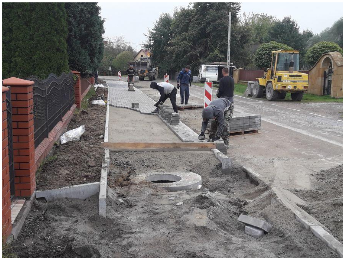
Remont drogi powiatowej relacji Padew Narodowa - Babule w m. Piechoty
