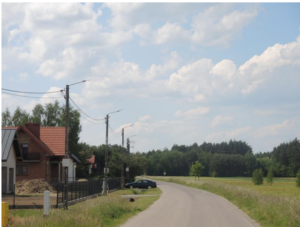
Budowa oświetlenia ulicznego przy ul. I. Łukasiewicza
