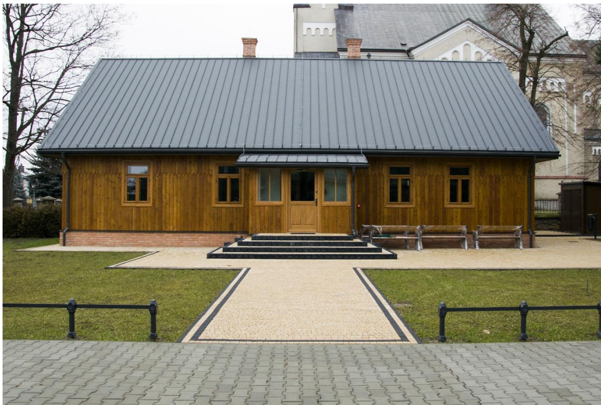
Budynek Centrum im. Ignacego Łukasiewicza w Padwi Narodowej
