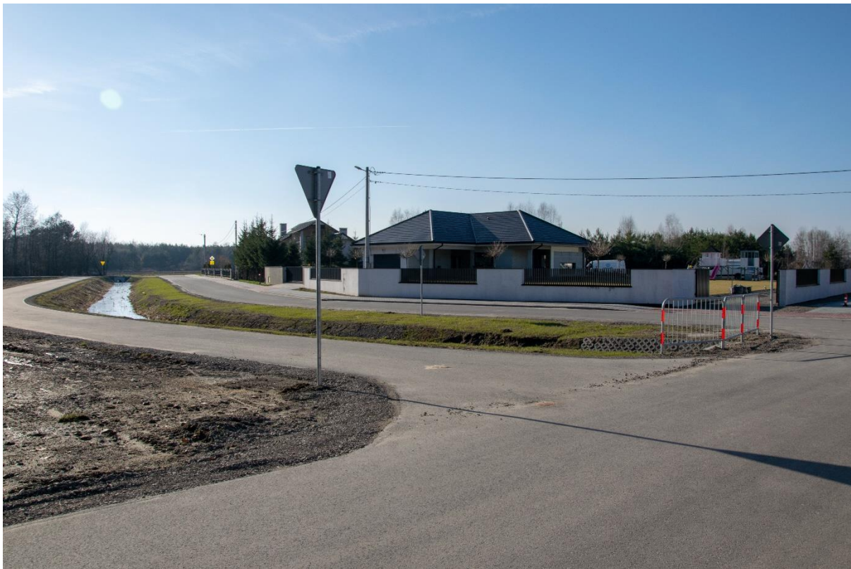
Nowe drogi w Gminie Padew Narodowa powstałe w 2022 r.
