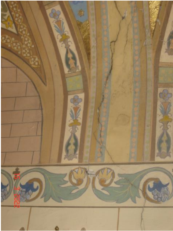
Pęknięcia i rysy ścian i sklepienia
