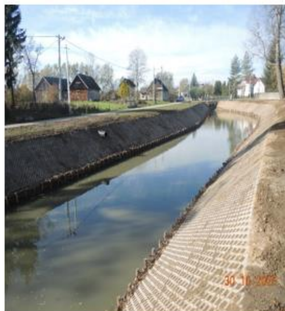
Budowa i renowacja zbiornika wodnego służącego małej retencji w obrębie Zaduszniki dz. ewid. nr 495/2
