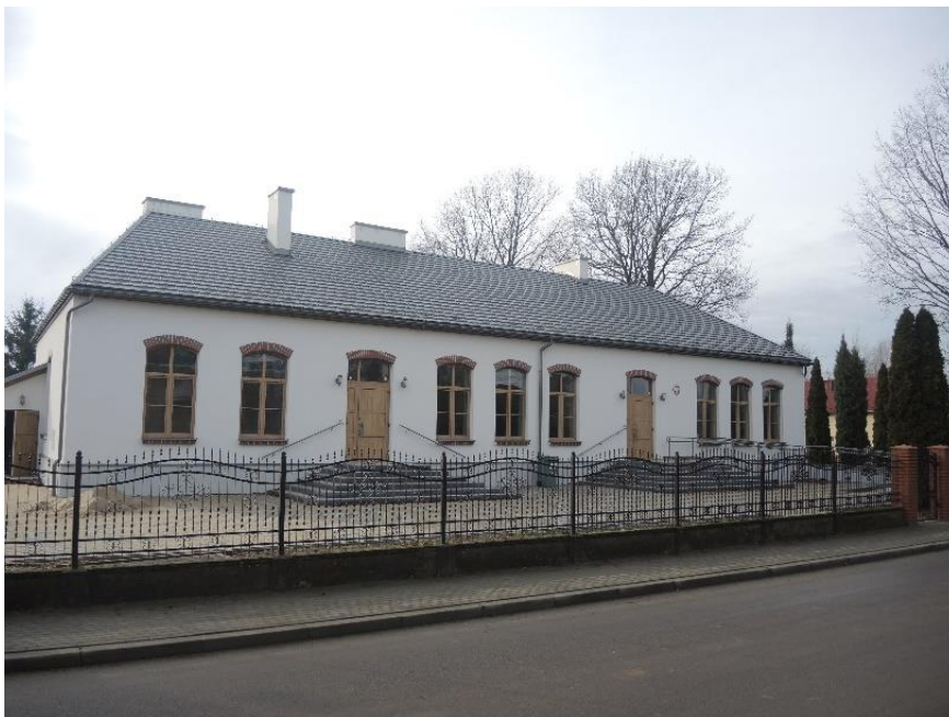
Wyremontowany budynek po byłej szkole w Zarówniu
