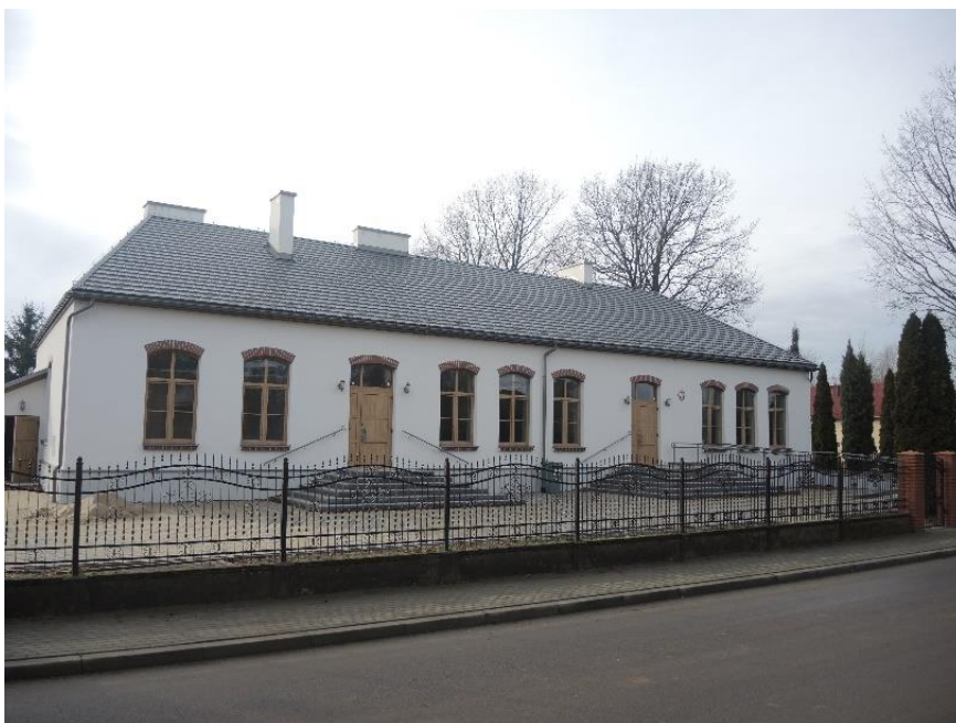
Wyremontowany budynek po byłej szkole w Zarówniu
