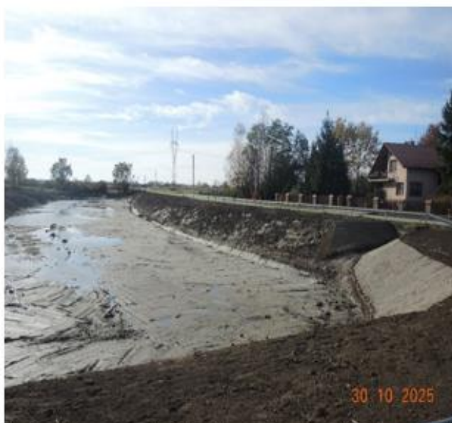
Budowa i renowacja zbiornika wodnego służącego małej retencji w obrębie Przykop dz. ewid. nr 904/5, Domacyny dz. ewid. nr 479/1,
