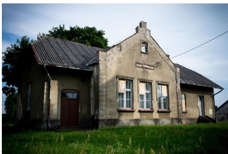
Budynek po dawnej Szkole Podstawowej w Kębłowie (przed remontem).
