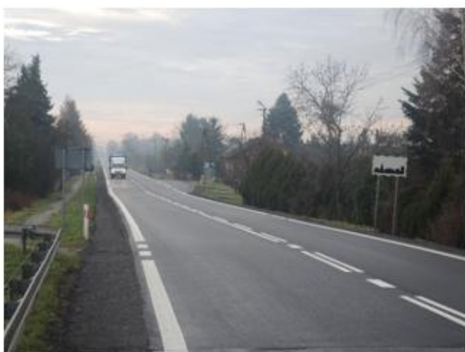
Remont (odnowa) drogi wojewódzkiej nr 985 relacji Nagnajów – Baranów Sandomierski – Mielec – Dębica w Padwi Narodowej w km 10+870-12+500 ( tj. od wiaduktu kolejowego za most rzeki Babulówka ).
